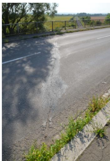
Obr.: Podpovrchový mostní závěr ve vozovce nad opěrou OP1 a nad opěrou OP2
