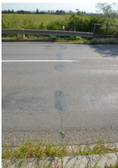
Obr.: Vozovka v místě konce přechodové oblasti před mostem a za mostem
