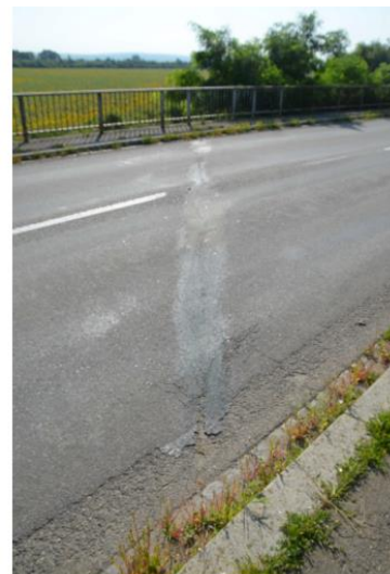
Obr.: Podpovrchový mostní závěr ve vozovce nad opěrou OP1 a nad opěrou OP2
