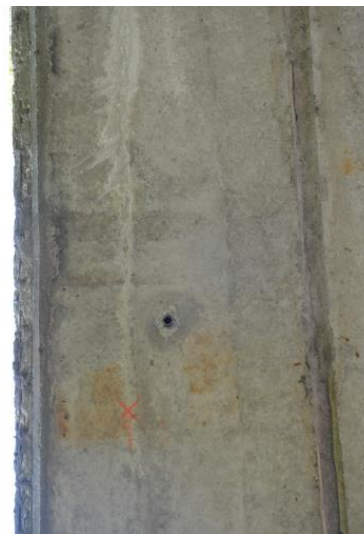
Obr.: Příklad trhliny pod kabelovým kanálkem na pohledu nosníku č. 1
