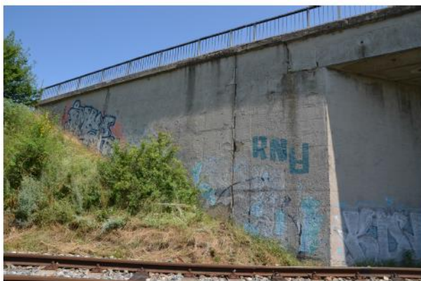
Obr.: Pohled na pravé křídlo u opěry OP1 (2 dilatační spáry)
