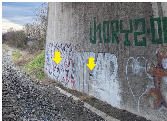
Obr.: Pohled na vyústění rubové drenáže v lici opěry OP2 (2 x trubka)
