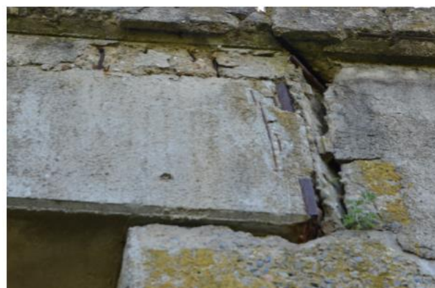
Obr.: Detail uložení nosníku č.11 (začátek a konec)
