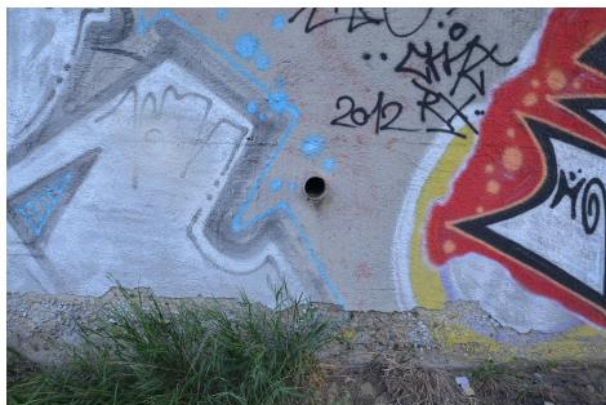
Obr.: Pohled na vyústění rubové drenáže v lici opěry OP1 (1 x trubka)
