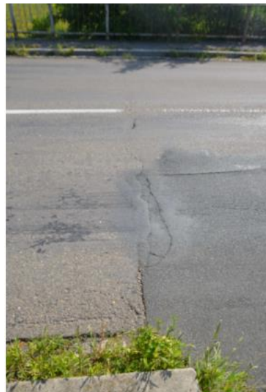
Obr.: Vozovka v místě konce přechodové oblasti před mostem a za mostem
