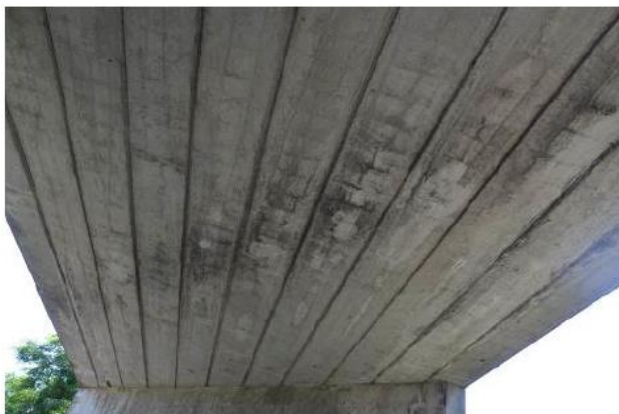
Obr.: Podhled na nosníky KA-67
